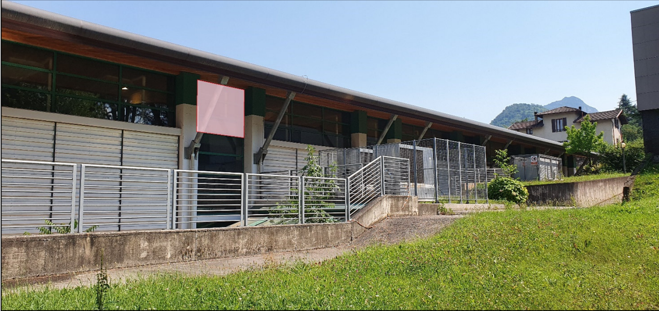
Foto – Individuazione apertura per scarico fumi – Edificio lato sud
